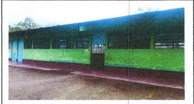
Foto1: Sustritiución de balcones
